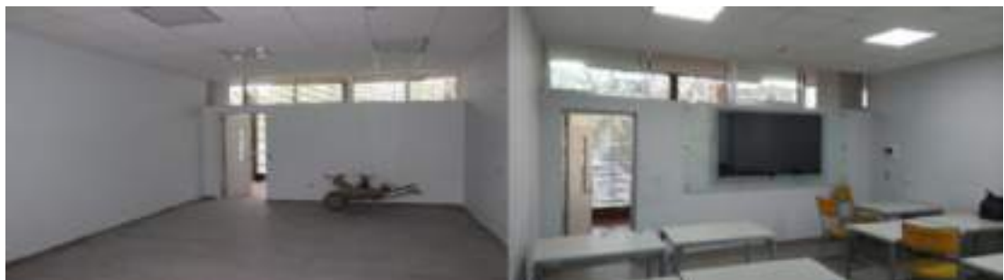
Figura 11. Aulas de la licenciatura en Diseño para la Comunicación Gráfica. (Izq.) Antes de la remodelación. (Der.) Después de la remodelación (Coordinación de Servicios Generales del CUAAD).
