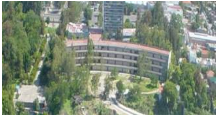
Figura 3. Vista aérea de aulas ala norte antes de la intervención (Coordinación de Servicios Generales del CUAAD).
